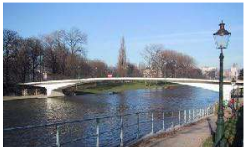
le pont Hennebique recent (internet)
